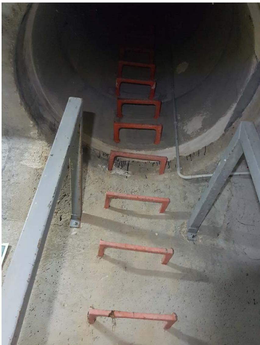
Al no existir espacio suficiente para dejar una plataforma de descanso a altura de 2 m, y no poder instalar una escalera inclinada en hueco existente, se cambiará el uso del acceso, limitándose solo a entrada de material.
