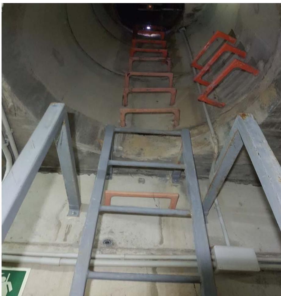
Al no existir espacio suficiente para dejar una plataforma de descanso a altura de 2 m, y no poder instalar una escalera inclinada en hueco existente, se cambiará el uso del acceso, limitándose solo a entrada de material.
