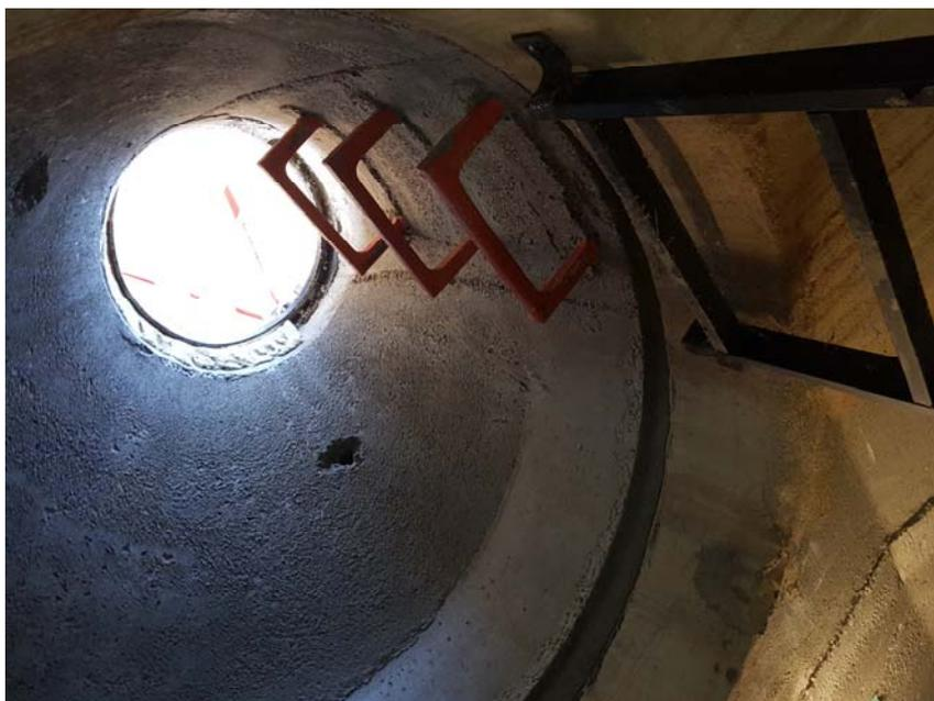
Cuenta con escalera vertical con pates de salida, siendo necesario la sustitución del pozo de registro de forma cónica de entrada por uno de mayores dimensiones para dejar un acceso de 0,80 m y poder instalar una escalera inclinada a  $70^\circ$  tipo barco inclinada con posa manos de unos 4 m de longitud y anchura de 40 cm, que soporte una sobrecarga de uso  $400 \text{ kg/m}^2$ , Euroclase A1 de reacción al fuego, según UNE-EN 13501-1 de acero galvanizado.
