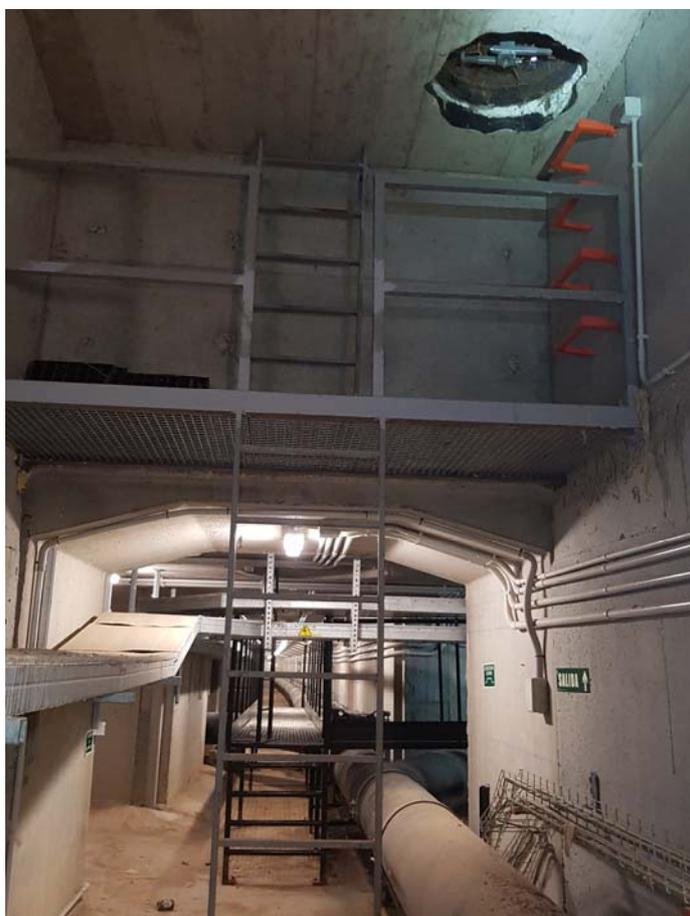
En la actualidad cuenta con escaleras con plataforma de descanso y barandilla de protección, con primer tramo a 2,5 m de altura del suelo de la galería realizado con plataforma de tramex y a 1,95m a espacio exterior seguro.
