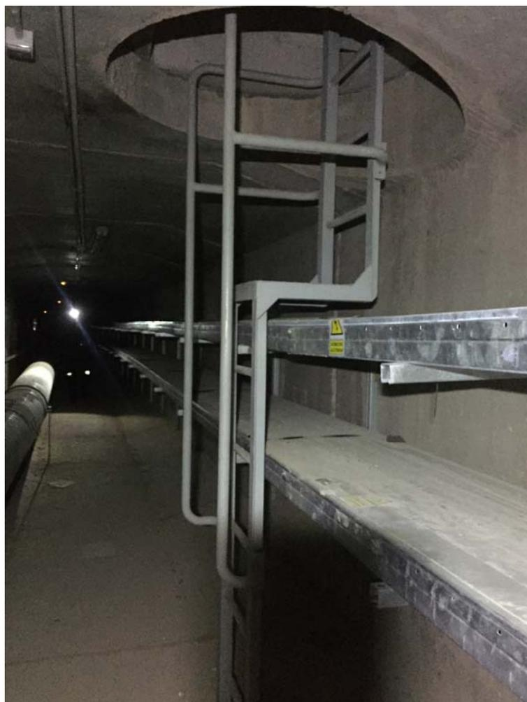
Acceso por el interior de túnel a unos 2,8 m de altura, escaleras verticales en dos tramos con barandilla lateral.
