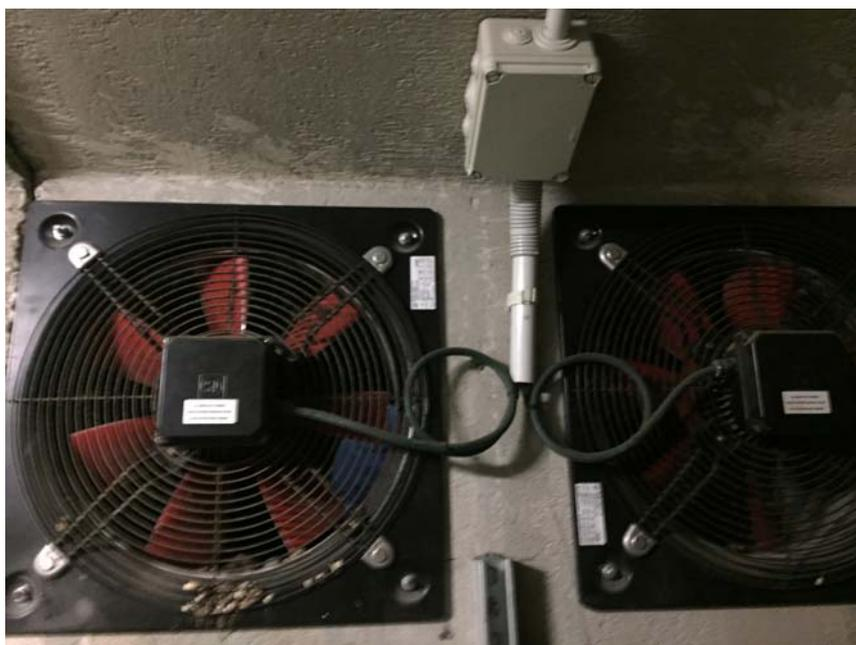
Los ventiladores están comunicados con el exterior mediante un tubo de 1 metro de diámetro de acero e = 5 mm con tratamiento anti óxido, y éste, a su vez, tendrá la salida al exterior mediante una pieza a modo de chimenea para la toma y extracción de aire con protección contra la lluvia, orientadas de forma que el viento dominante no les afecte y diseñadas para mimetizarse con el entorno.
